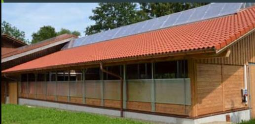
Die Standard Hubfenster lassen sich in Kombination mit dem Lichtfirst in einer Steuereinheit miteinander verbinden. Diese Steuerung ermöglicht eine automatische Anpassung der Elemente in Abhängigkeit von den Temperatur- und Windverhältnissen.
