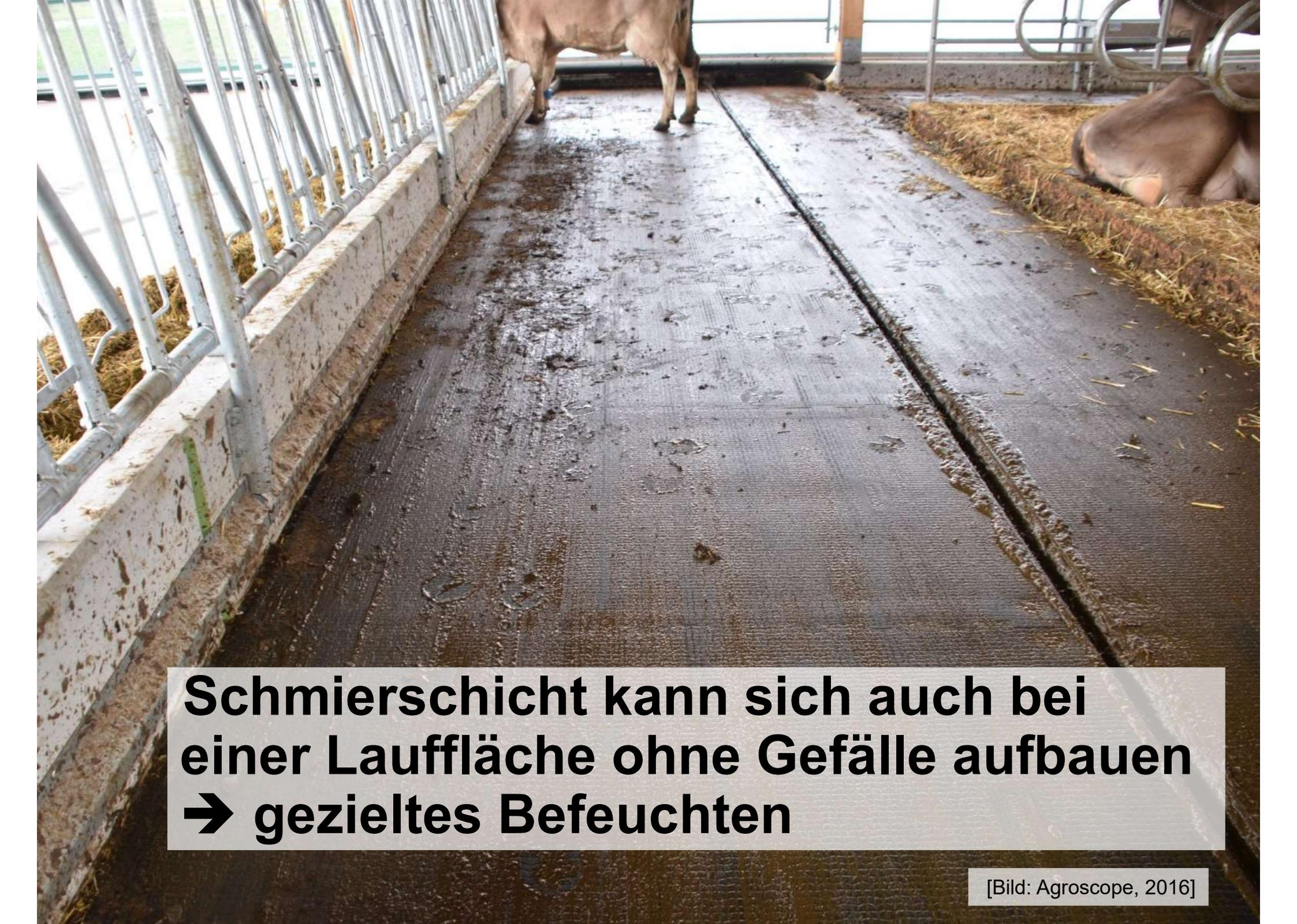
**Schmierschicht kann sich auch bei einer Lauffläche ohne Gefälle aufbauen
