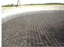
Hexa-Cover, eine Möglichkeit der Abdeckung von Güllebehältern
